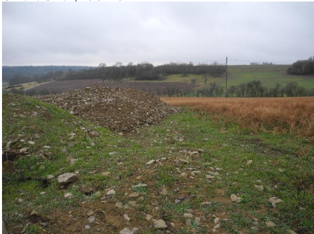
11) Südrand mit aktueller Baustelle und Erdaushub © Klärle GmbH, 20.01.2022
